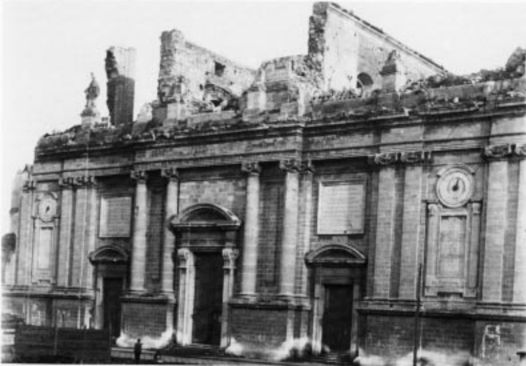
Zaera. Chiesa della Maddalena di Carlo Marchionni (1765/1834): la facciata parzialmente demolita dopo il disastro del 1908 (Archivio del Museo Regionale di Messina). Foto tratta da I volumi "I Borghi di Messina" di Franco Chillemi, Ed. EDAS, 1994.
